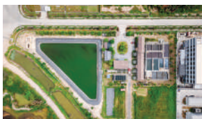
NHÀ MÁY XỬ LÝ NƯỚC THẢI
