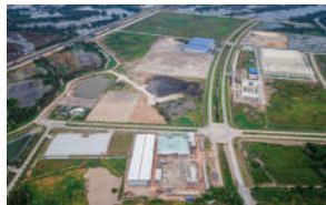
KHU VỰC HOÀN THÀNH CƠ SỞ HẠ TẦNG
